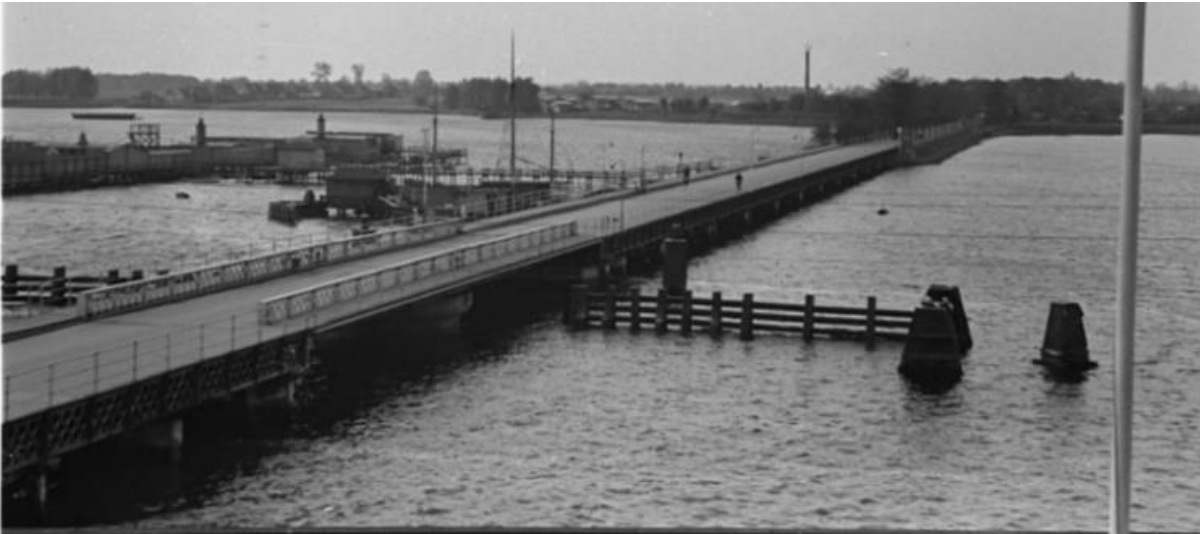
Christian d. 9's bro fra efter 1930'erne. Den 40-meter lange svingbro er placeret ud fra bolværket og har et anderledes rækværk end resten af broen. Svingbroen hviler på en stor bærepille af beton, der har kunnet bære drejemekanismen.
