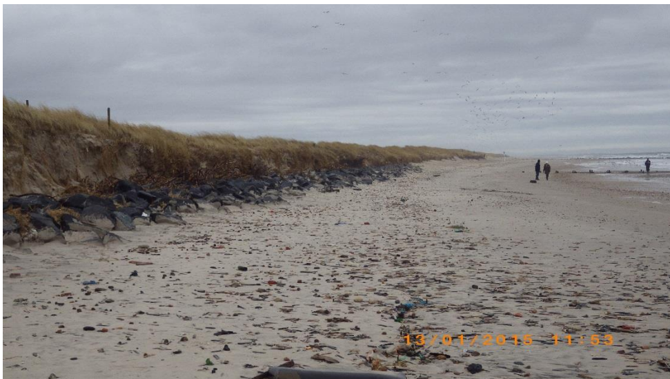
Figur 3C-2. Billede taget i den nordlige ende af Fællesaftalestrækningen omkring hofde 1, strækkende sig videre mod syd. Billedet dækker dele af den strækning hvor der ansøges om at kystbeskytte.
