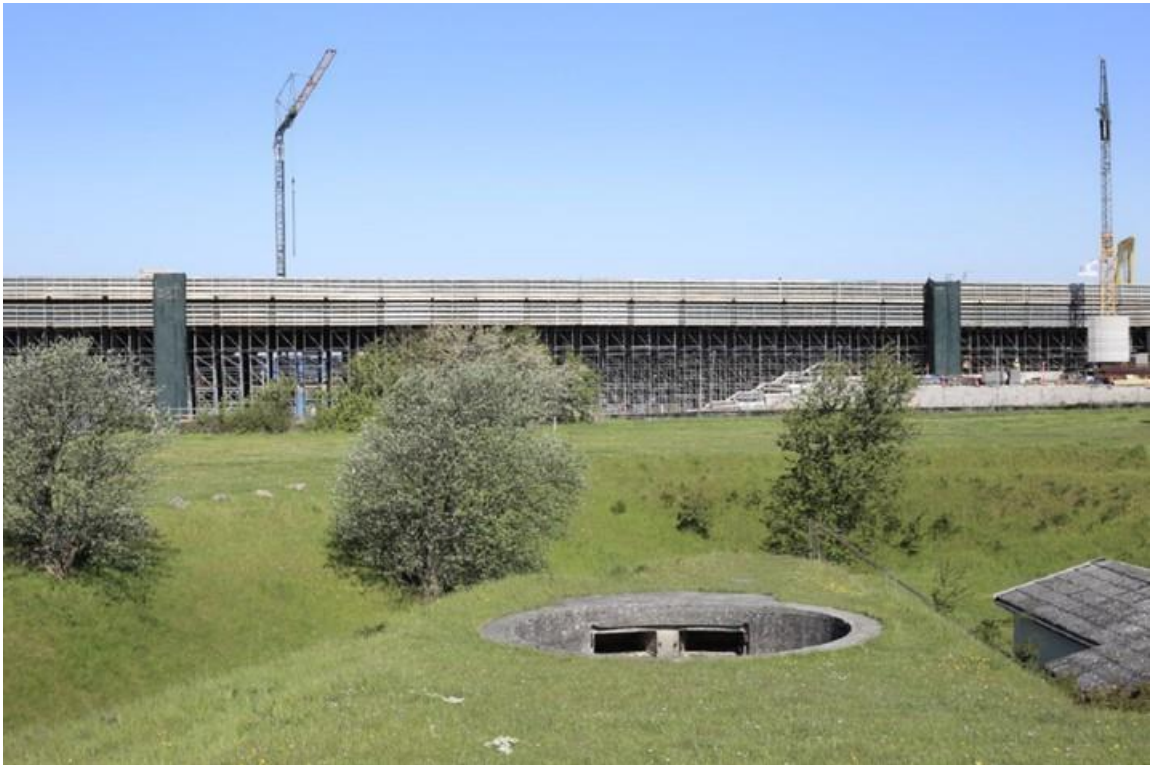
Figur 15-8 De eksisterende forhold set fra fotostandpunkt 6.
