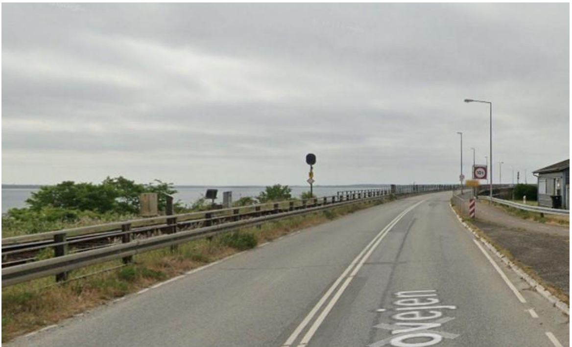
Figur 6-6. Storstrømsbroen set mod syd (Google Maps, 2023).
