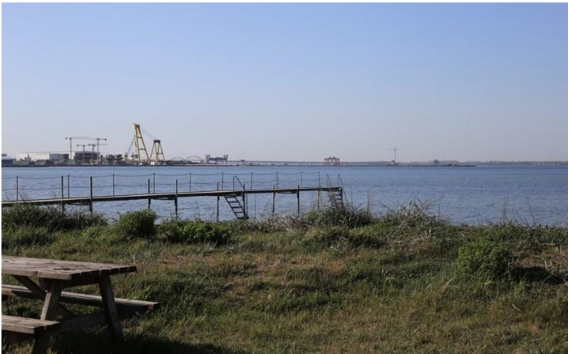
Figur 15-5. De eksisterende forhold set fra fotostandpunkt 2.
