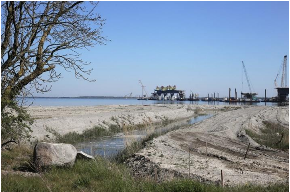
Figur 15-2. De eksisterende forhold set fra fotostandpunkt 4.
