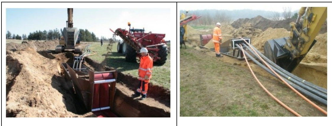
Figur 2: Eksempel på kabelnedlægning med gravekasse.
