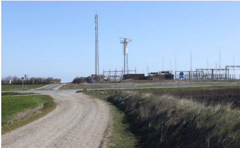
Figur 5: Visualisering af radarmast på stationsområdet ved Søndervig. Radaren placeres i toppen af gittermasten. Masten til venstre er en eksisterende telemast.
