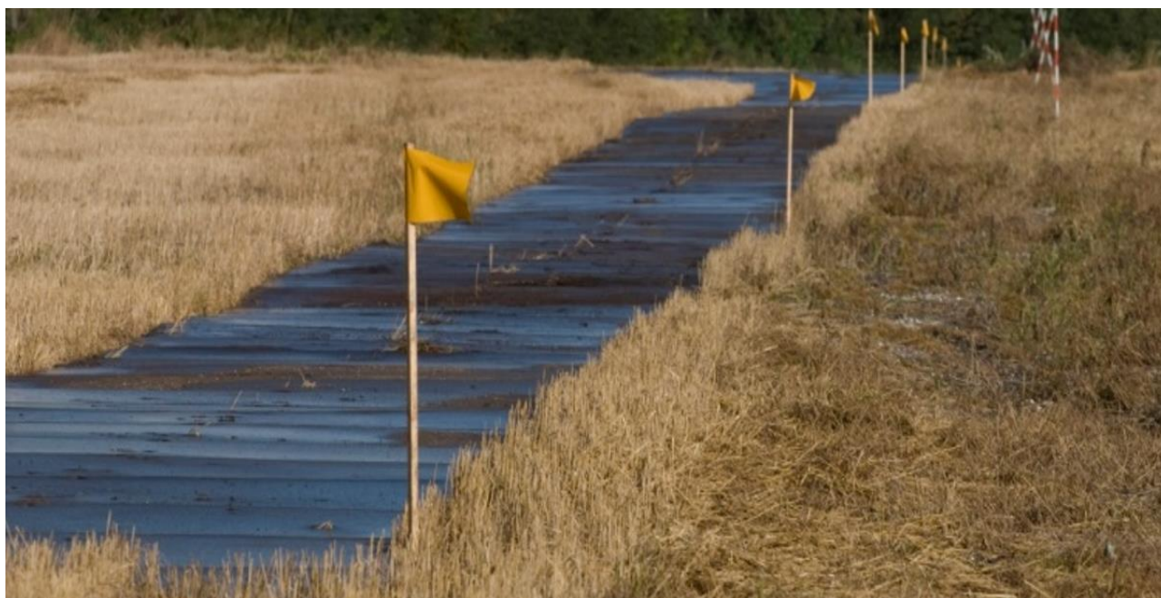
Figur 2-10 adgangsvej med køreplader
