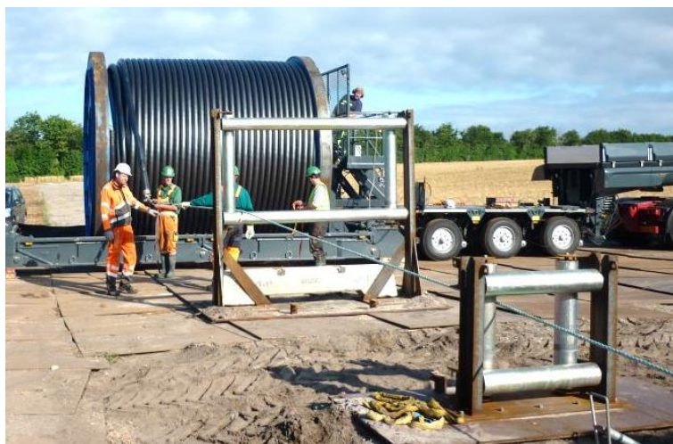
Figur 2-14 Kabeltromle på blokvogn
