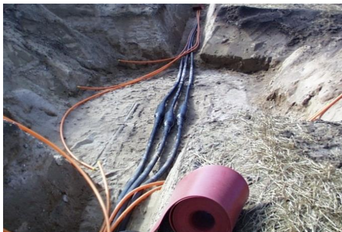
Figur 2-12 Kablerne er muffet sammen
