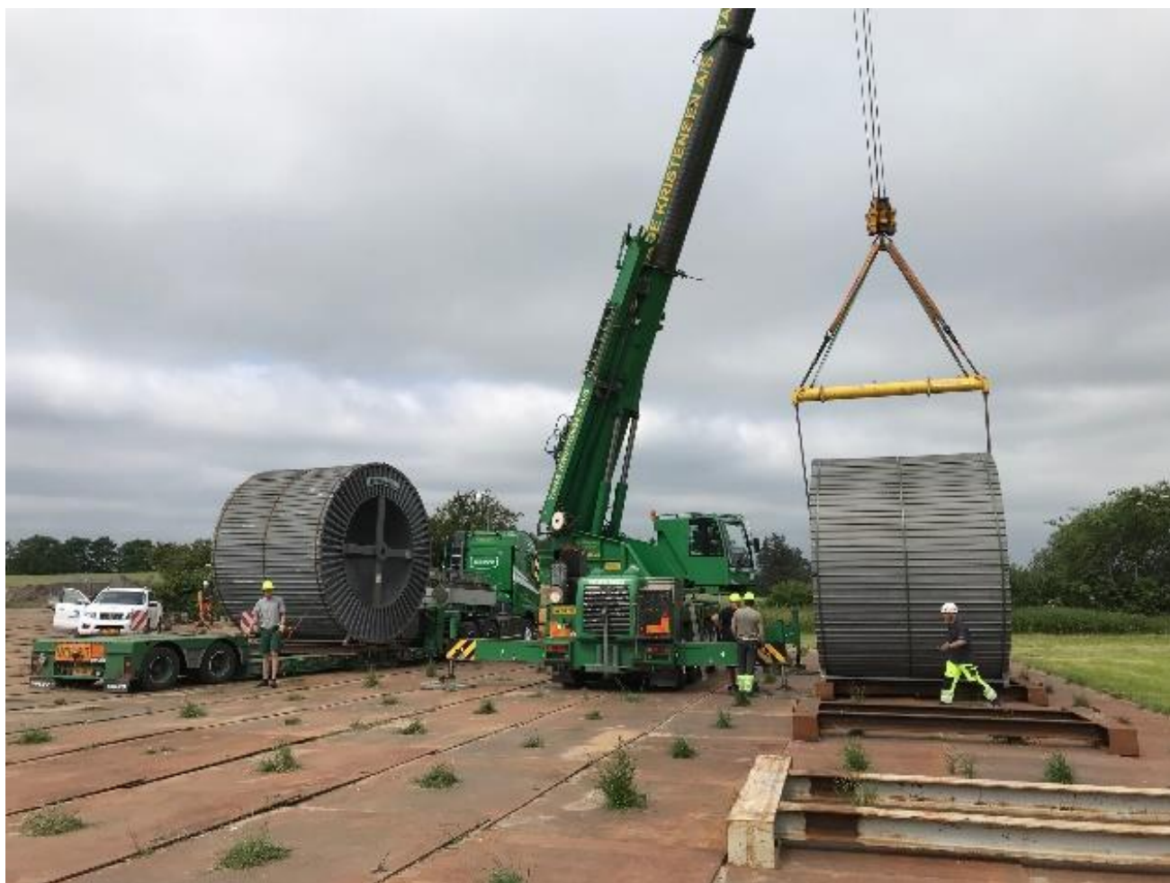
Figur 2-8 Håndtering af kabeltromler på tromleplads
