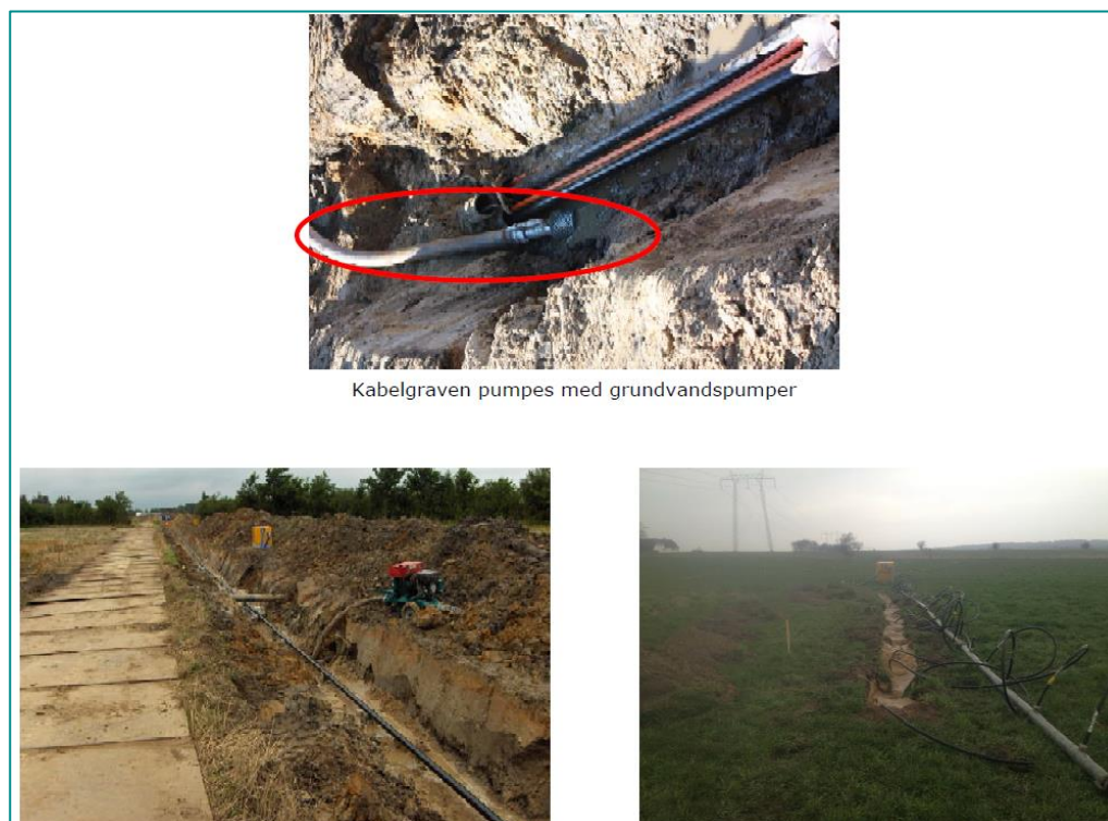
Figur 2-7 Forskellig metoder til at holde kabelgraven tør. På billedet til venstre etableres drænrør, til højre etableres sugespidsanlæg
