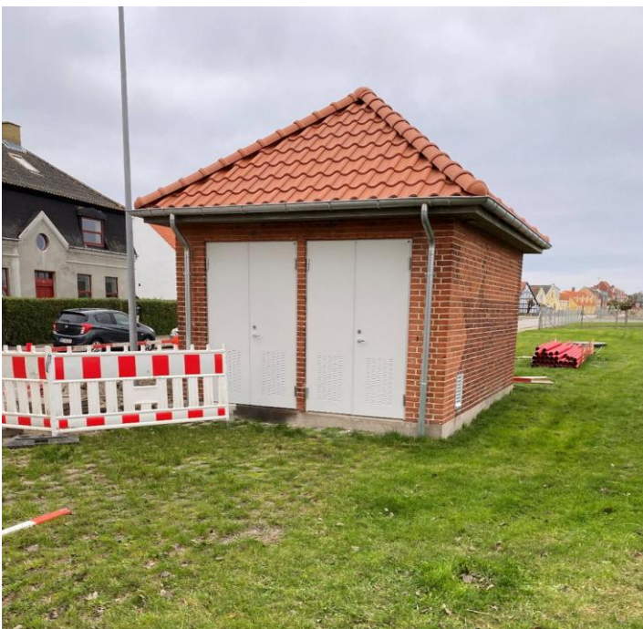
Figur 2-5 Zeanet teknikhus, hvor højvandsbeskyttelsen skal omkring. Dette teknikhus er beliggende på nordligste del af Forsvarets matrikel.
