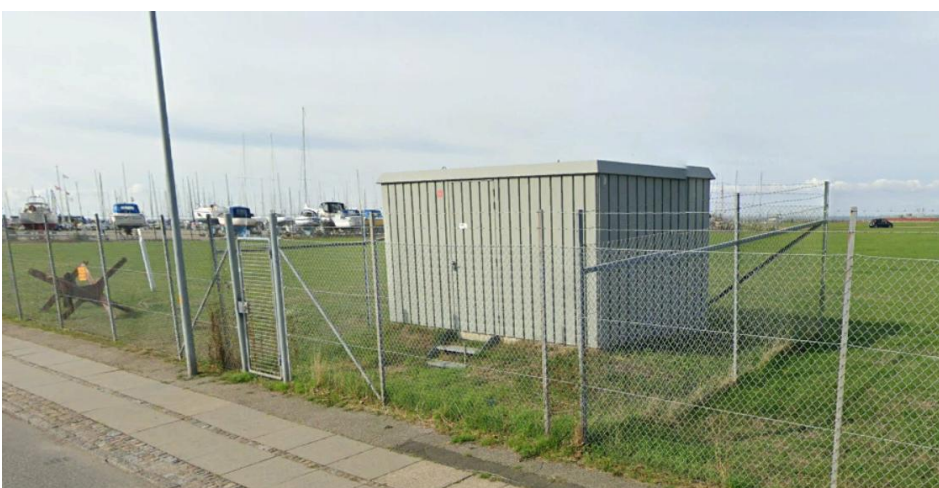
Figur 2-12 Teknikskab ved Sylowsvej. Dette er placeret i den sydlige halvdel af Flådestationen. Billede fra Google streetview.
