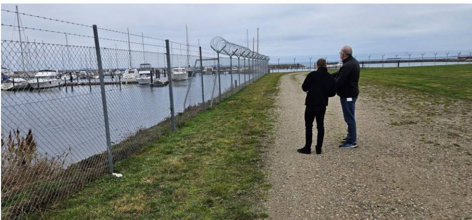
Figur 2-15 Servicevejen langs indfatningen i nordøstlige del af lystbådehavnen.
