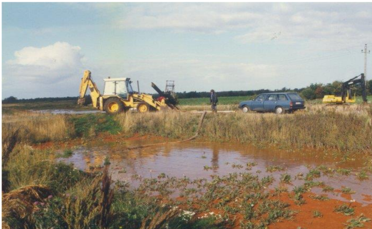
Fig. 5. Eksempel på oppumpning af okkerslam til slambed ved Hvidmose anlægget
