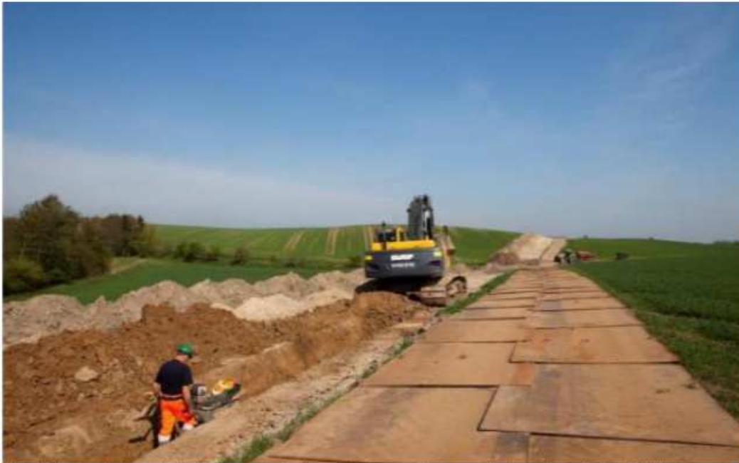
Figur 4 Eksempel på arbejdsbælte langs kabelanlæg med aførmet rå- og muldjord samt køreplader. På billedet ses et kabeltracé med ét kabelanlæg.
