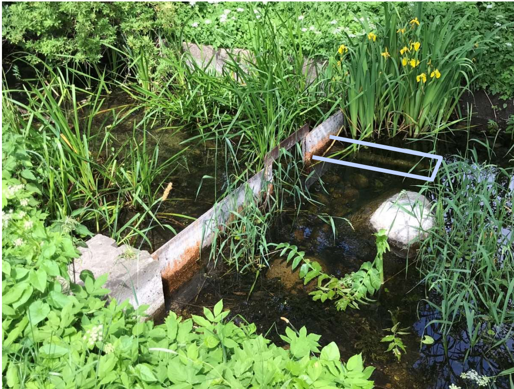
Figur 5. Det eksisterende stemmeværk i kanalen, som forbinder Søndersø og Tibberup Å, juni 2020. De grå streger markerer placeringen af en rørgennemføring i den østlige side af stemmeværket.
