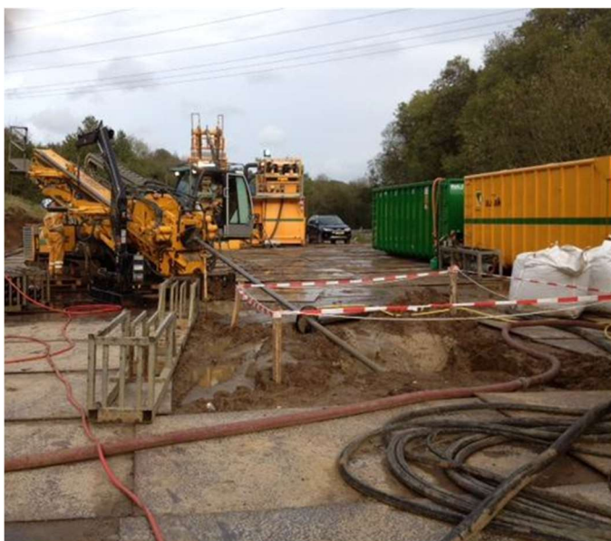
Eksempel på arbejdsareal ved styret underboring
