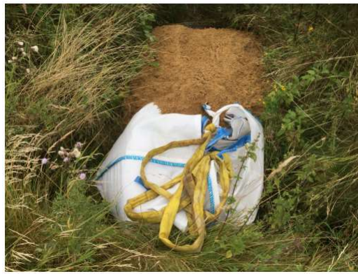
Eksempel på et blow-out med boremudder i en bæk, samt inddæmning med sandsække
