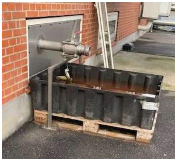
Figur 4. T.v.: Tilsvarende setup med spildbakke er på den anden side af bygningen til afhentning af fejlfermenteringer. T.h.: Eksempel på fjederbelastet afspærringsdæksel (anden lokalitet).
