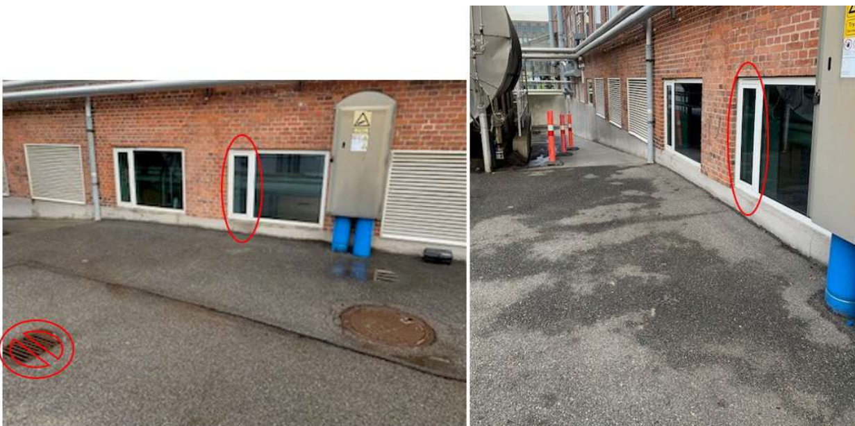
Figur 3. Afhentningspladens for tankbilen. Lastbilen vil bakke ind skråt udefra indtil 4 meter fra muren, og der vil blive optegnet afgrænsningslinier på asfalten, så risikoen for påkørsel af udstyr langs ydermuren, herunder rør og gasflasker er ringe. Den røde cirkel angiver hvor udtag fra fermenteringstankene vil være placeret. Symbolet ⚡ angiver hvor regnvandsafløb spærres under afhentning af fermenteringsvæsken (se også fig.5, hvor afløb nedenfor rampen også er angivet)
