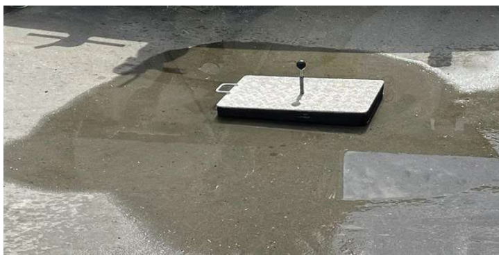
Figur 4. T.v.: Tilsvarende setup med spildbakke er på den anden side af bygningen til afhentning af fejlfermenteringer. T.h.: Eksempel på fjederbelastet afspærringsdæksel (anden lokalitet).
