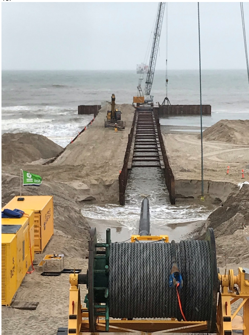
Figur 13 Spunset ledningsgrav, hvor gasrørledningen ilandføres ved kysten.
