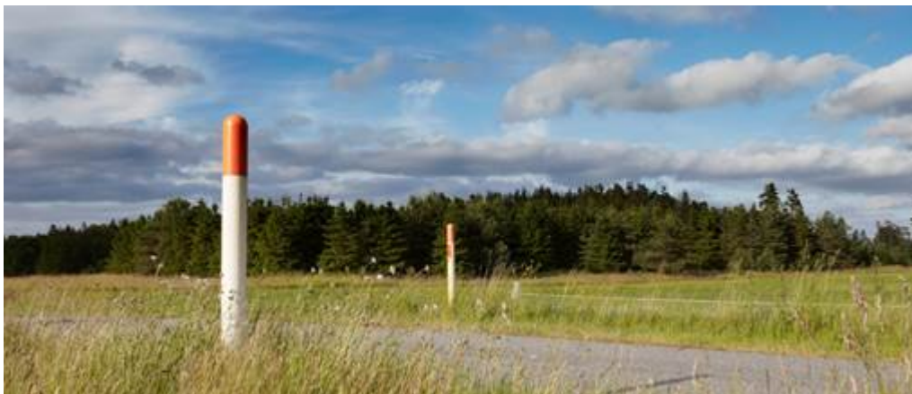
Figur 15 Når rørledningen er lagt, vil der langs bæltet blive sat gule markeringspæle
