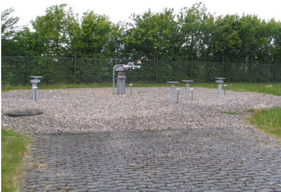
Figur 4 Eksempel på linjeventilstation
