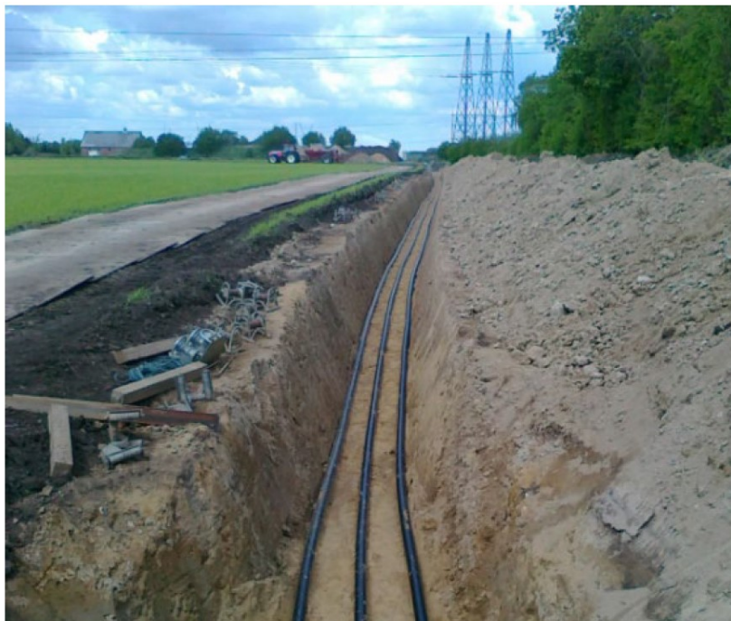
Figur 6 Eksempel på kabelgrav (enkelttrace) med køreplader til venstre og jordoplag til højre.
