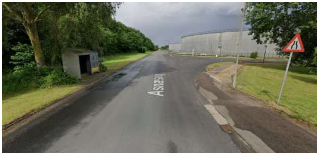
Figur 7-7: Krydsudformning ved det potentielle konfliktpunkt 1. Manglende afmærkning og skiltning af den dobbeltrettede cykelsti. Billede fra Google Maps (2022).
