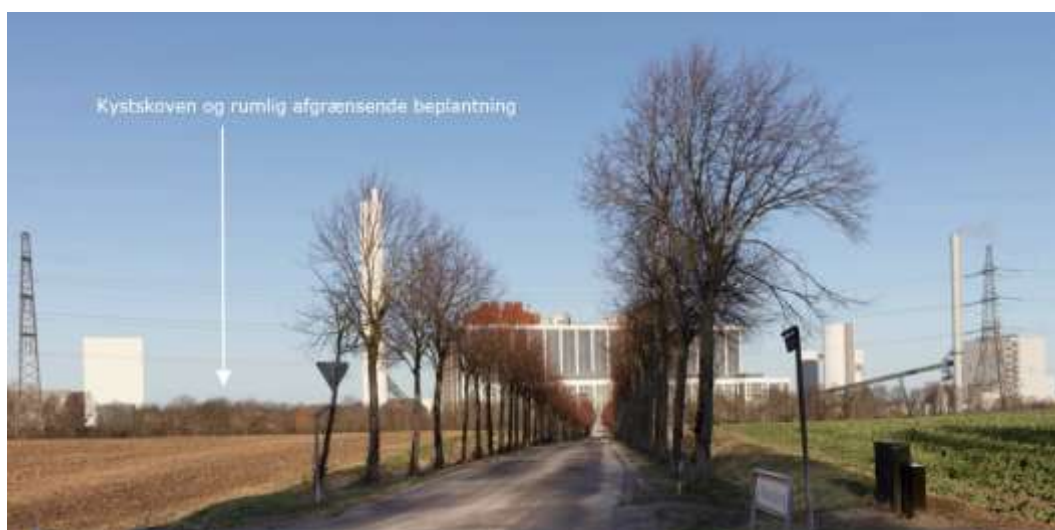
Figur 8-5: Asnæsværket set mod nord. Arealet er rumligt afgrænset af et beplantningsbælte, men værket er stadigvæk grundet dets højde og volumen dominerende i landskabet.
