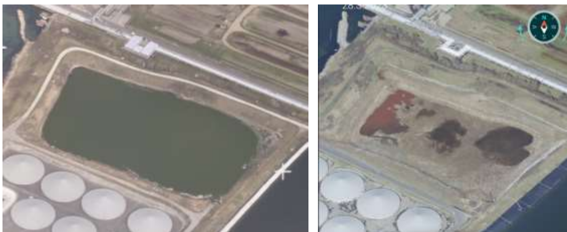
Figur 10-25 Luftfoto af bassin (2019), hvor bassinet er fyldt med saltvand (venstre). Luftfoto af bassin (2023) med tydelige aflejring af okker (højre). kilde: skraafoto.dataforsyningen.dk
