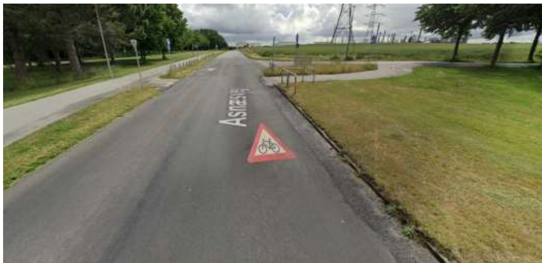
Figur 7-8: Krydsudformning ved det potentielle konflikt punkt 2. Der fremgår advarselsafmærkning på kørebanen samt afmærkning og tavler for de lette trafikanter der har vigepligt. Billede fra Google Maps (2023).
