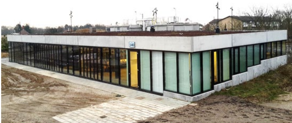
Figur 1: Foto af et tilsvarende renselanlæg på Herlev Hospital. Procestankene ses i baggrunden.
