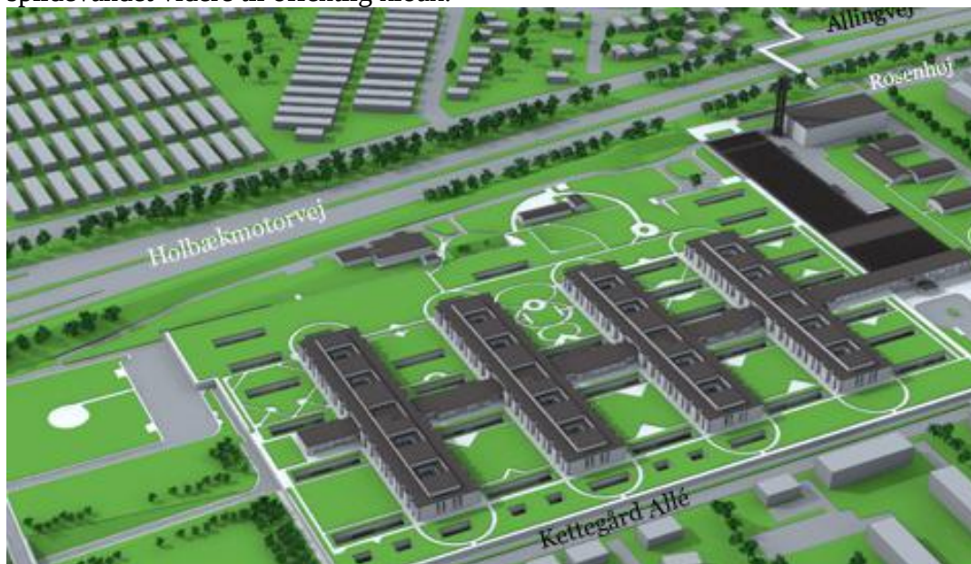
Figur 5-5 Kort over de fire centre på Hvidovre hospital. Den lave sorte bygning (th.) indeholder servicefunktioner som driftscentral, sterilcentral og centralkøkken. (Billede fra www.hvidovrehospital.dk ).
