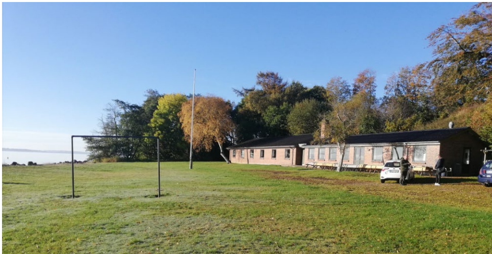
Fig. 2. Nuværende bygninger på Skræppedalsvej 49.
