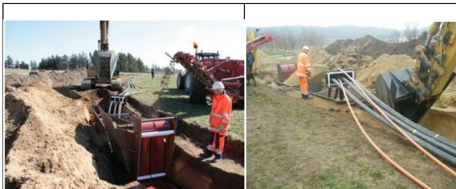
Figur 5: Kabelnedlægning med gravekasse.
