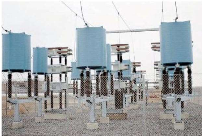
Figur 12: Eksempel på harmonisk filter.
