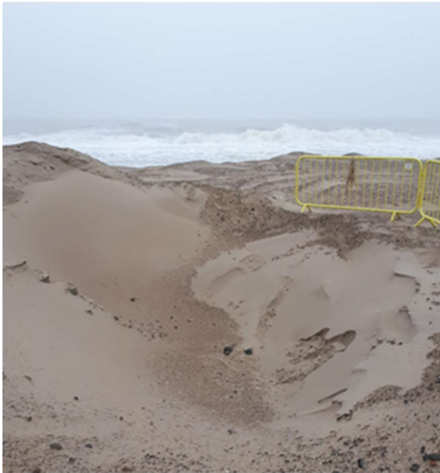
Figur 10: 5. september 2019 flød boremudder ud af underboringens starthul på stranden ved Vejlbj Klit.
