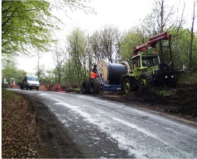
Figur 2: Kabeltromle anbragt i udstyr klar til udtrækning.
