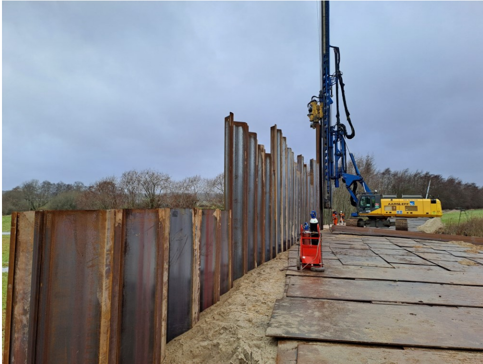
Spuns til venstre i færdig niveau – øvrige spuns er opsat i styringsniveau
