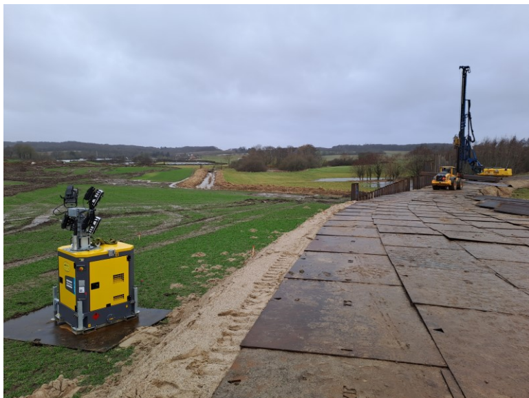
Kørevej og modhold langs spunsvæg med Alling Å i midten
