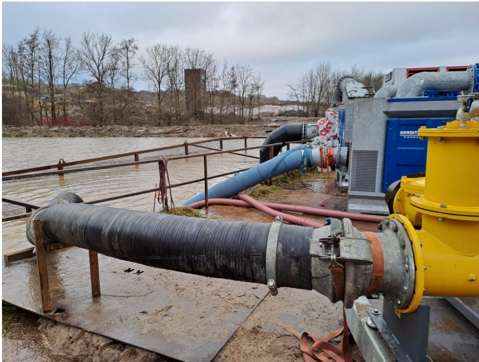
Rentvandsbassin – forurenet vand bag dæmningen midt i billedet. 2 andre pumper kører her.
