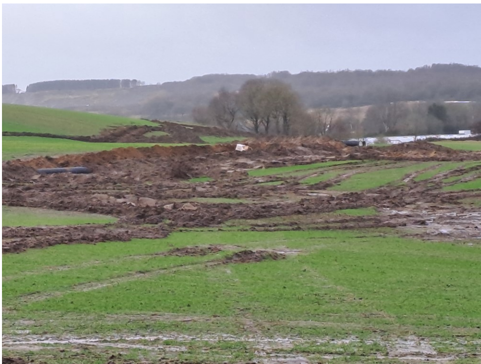
Foto mod sydvest, hvor rørgrav ses
