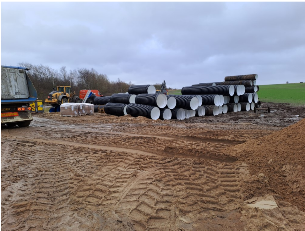
1.000 mm røret er under nedgravning fra østsiden.
