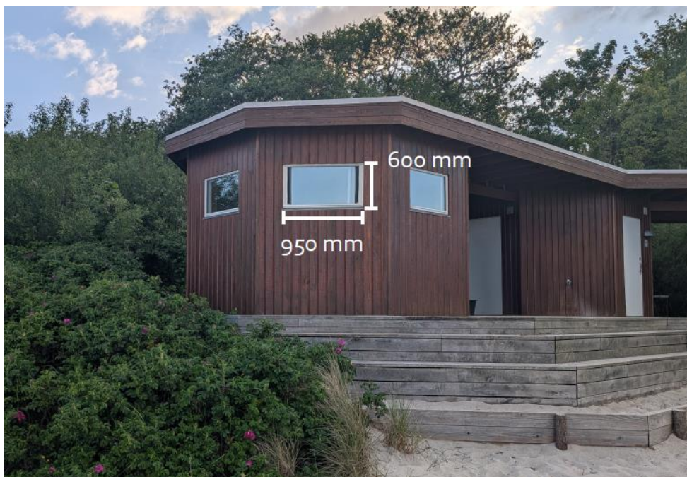
Fig. 10. Tilsendt fra ansøger. På figuren ses en illustration af det ansøgte vindue på saunabygningen, hvor det ansøgte vindue er markeret med hvide streger med mål.
