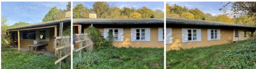
Fig. 8. Billeder indsendt af ansøger hvorpå sommerhusets eksisterende nordøstlige facade og overdækkede terrasse kan ses.
