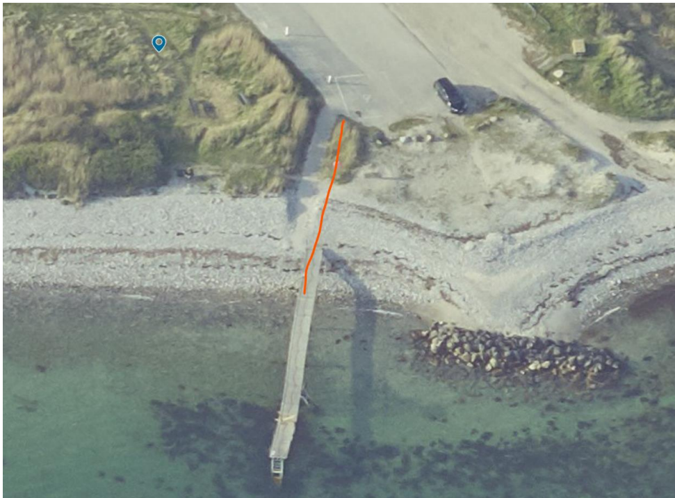
Skråfoto af området. Eksisterende betonrampe ses til venstre for den røde markering.
