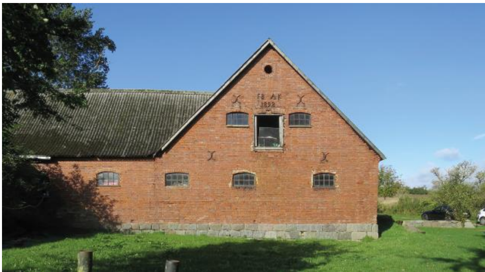
Foto af eksisterende forhold. Kostald set fra øst
