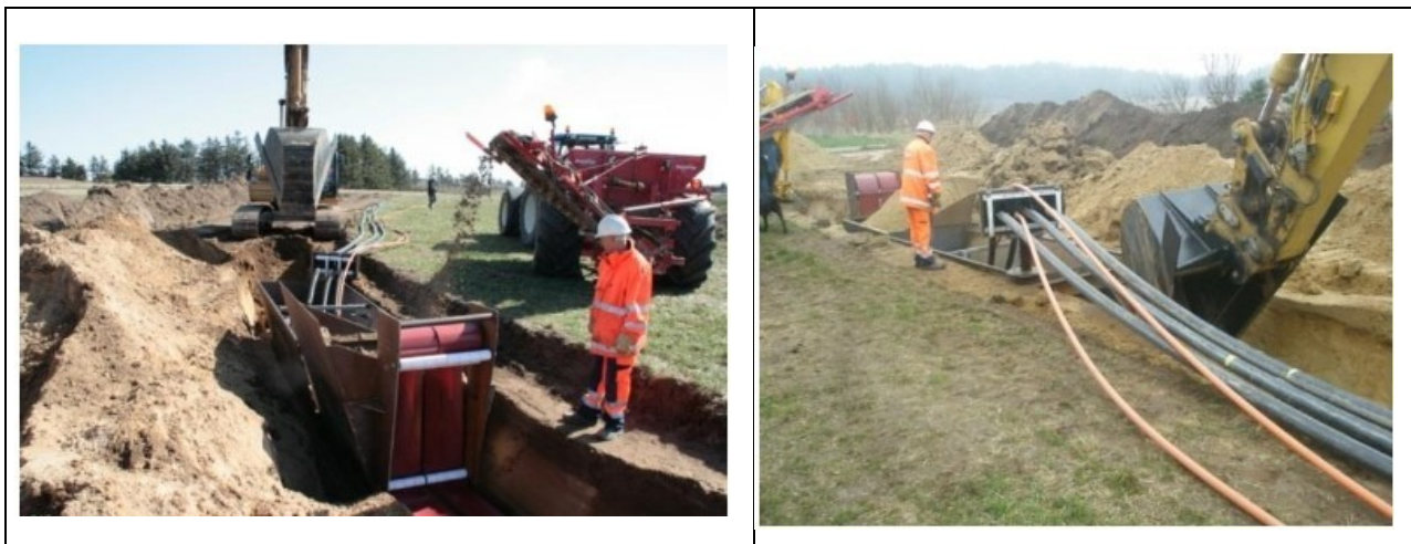
Figur 2: Eksempel på kabelnedlægning med gravekasse.
