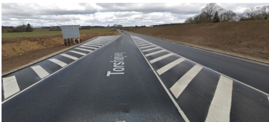
Figur 5. Støjvolden på den østlige side af Torshøjvej.
