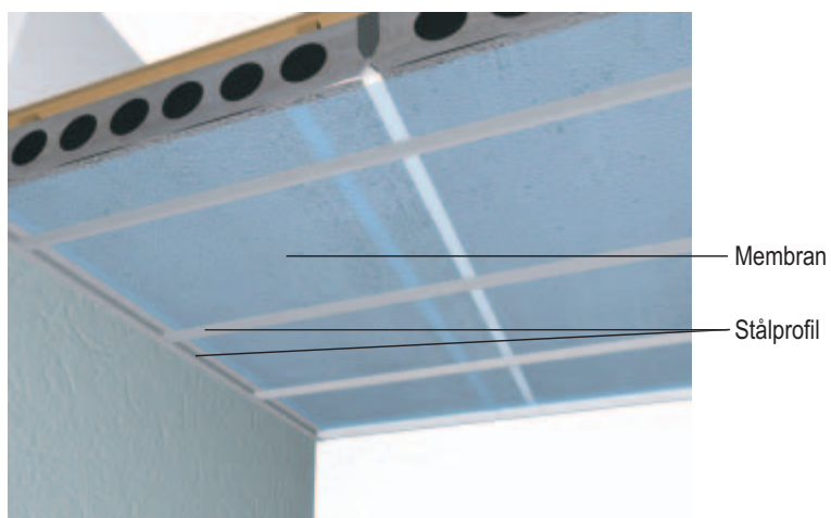
Figur 16. Hvis den anvendte membran ikke har en lille brændværdi, skal der opsættes et sænket loft af klasse A materialer, fx gipsplader på stålprofiler. Stålprofilerne skal fastgøres på væggene for at undgå at ødelægge membranen. Det sænkede loft opsættes umiddelbart under det eksisterende loft, for detaljer se fremgangsmåden i afsnittet Tætte sænkede lofter med ventilation i hulrummet.
