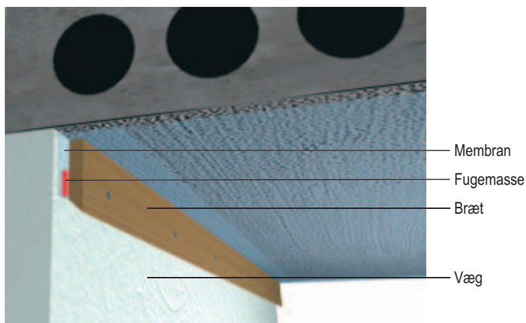
Figur 15. Samlingen mellem membran og væg dækkes af et bræt for at sikre, at membranen ikke med tiden løsner sig fra væggen. Hvis væggen er meget ujævn kan brættet, inden det sættes op, påføres en stribe fugemasse, som kan udligne ujævnhederne.
