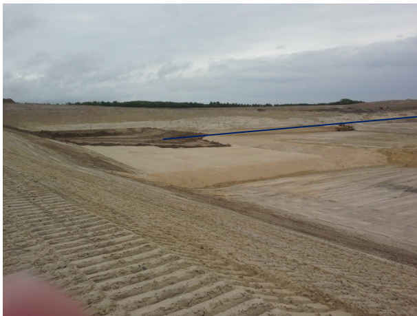
Billede 1: Udlægning af lermembran
