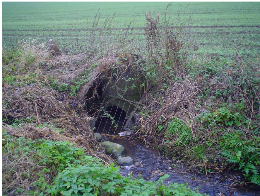
Rørlagte vandløbsstrækninger kan være alvorlige hindringer for vandløbsfaunaens naturlige vandringer – som her, hvor dyrene ikke kan komme op til en opstrøms liggende åben strækning. Hvis det er muligt at skabe adgang til en sådan opstrøms strækning, er det til stor gavn for den økologiske tilstand i hele vandløbssystemet. Foto: Jette Hansen.
