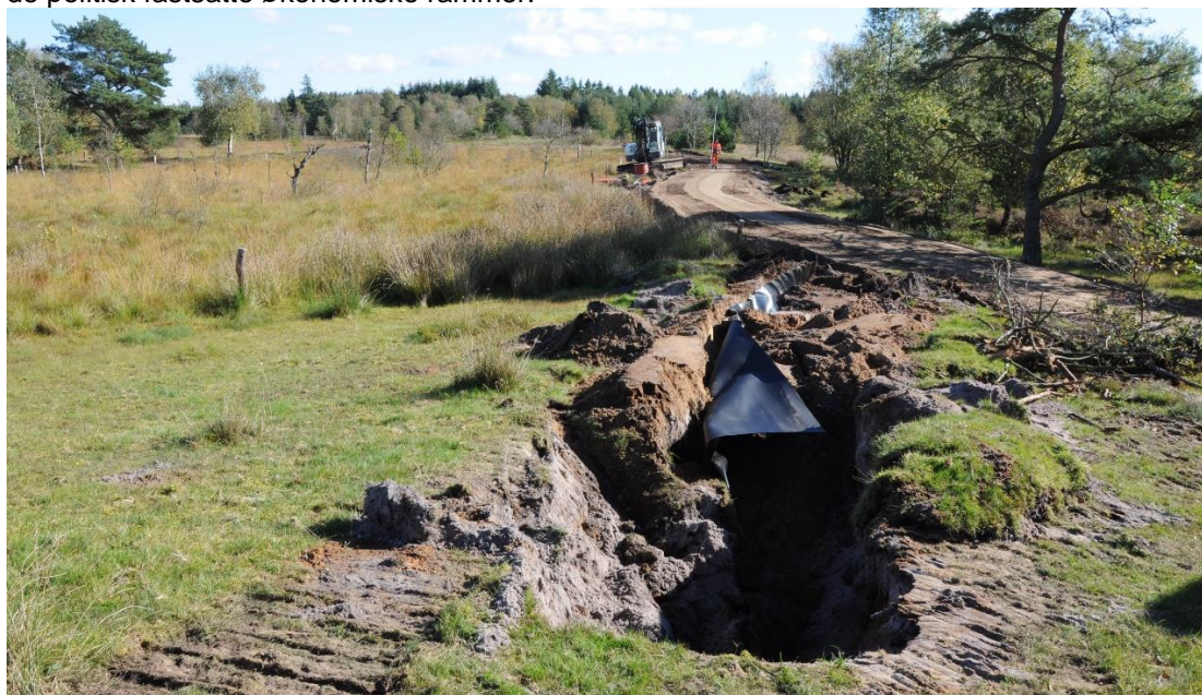
Nedlægning af membran i forbindelse med LIFE-projektet "LIFE70", for at hæve vandstanden i Stenholt Mose, med habitatnaturtyperne aktiv højmosse og nedbrudt højmosse. Foto: Silkeborg Kommune
