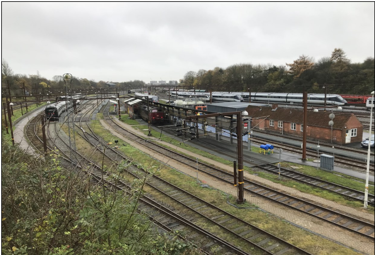
Figur 1. Baneterrænet nord for de eksisterende værksstedsbygninger ved Fredericia
