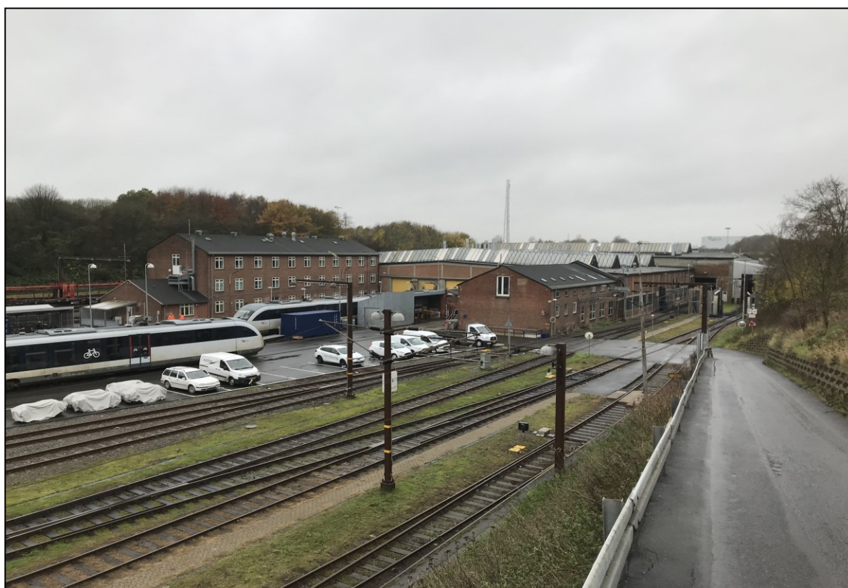
Figur 2. Spor, værksteds- og kontorbygninger ved baneterrænet i Fredericia set fra Egumvej. Det nye værksted etableres som en udvidelse af dette værksted.
