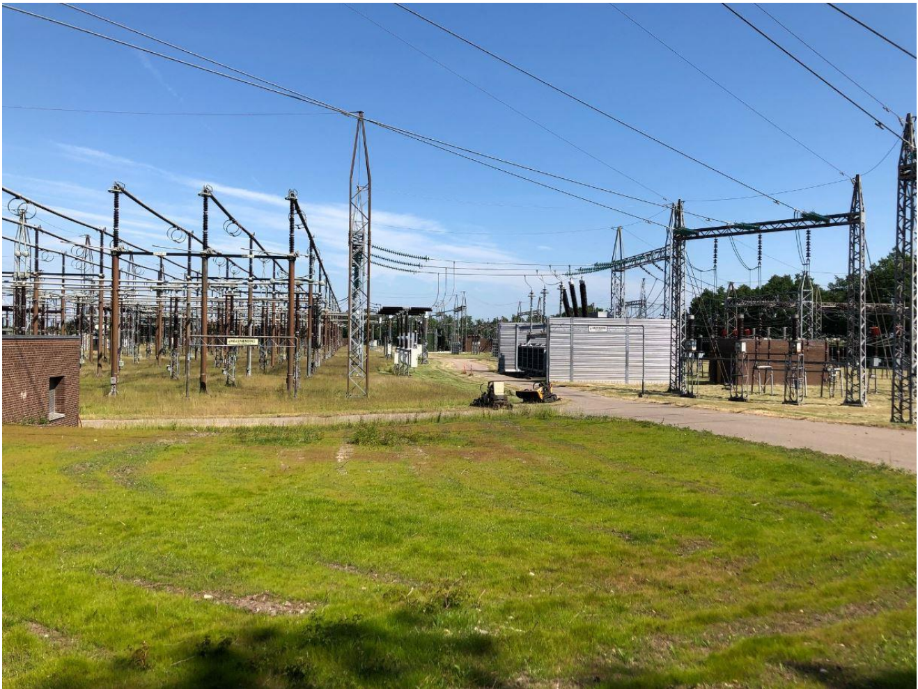
Figur 5.1: Støjskærm ved T41
