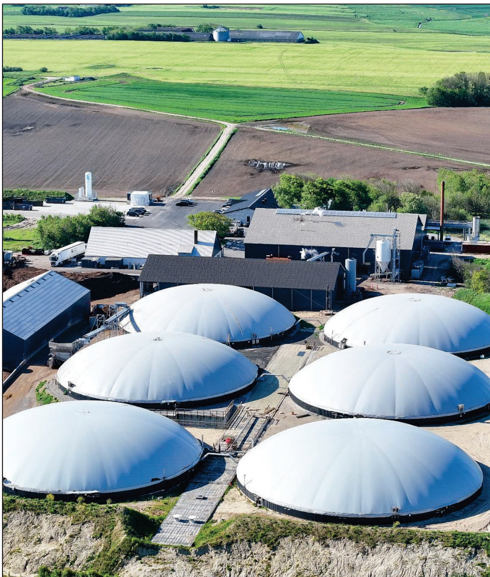
Figur 2 – Dronefoto af Agri Energy Vrå, med de 6 reaktortanke forrest i billedet, og haller til dybstrøelse, fiberseparation og pyrolyseanlæg i baggrunden.
