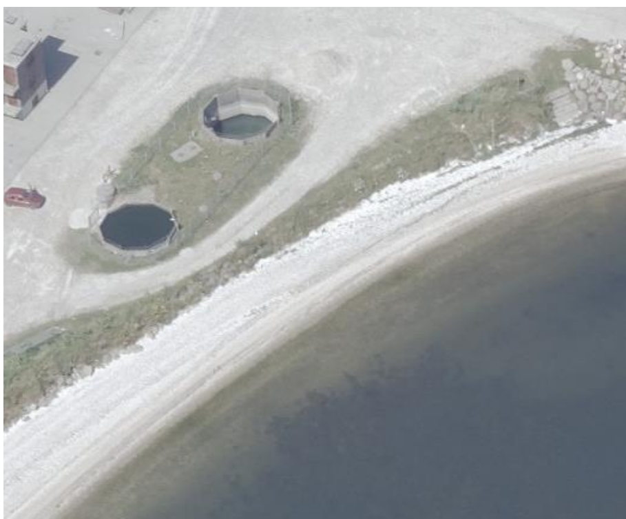
Figur 2 - Luftfoto af eksisterende jordvold fra Skråfoto.dk taget i juli 2021.
