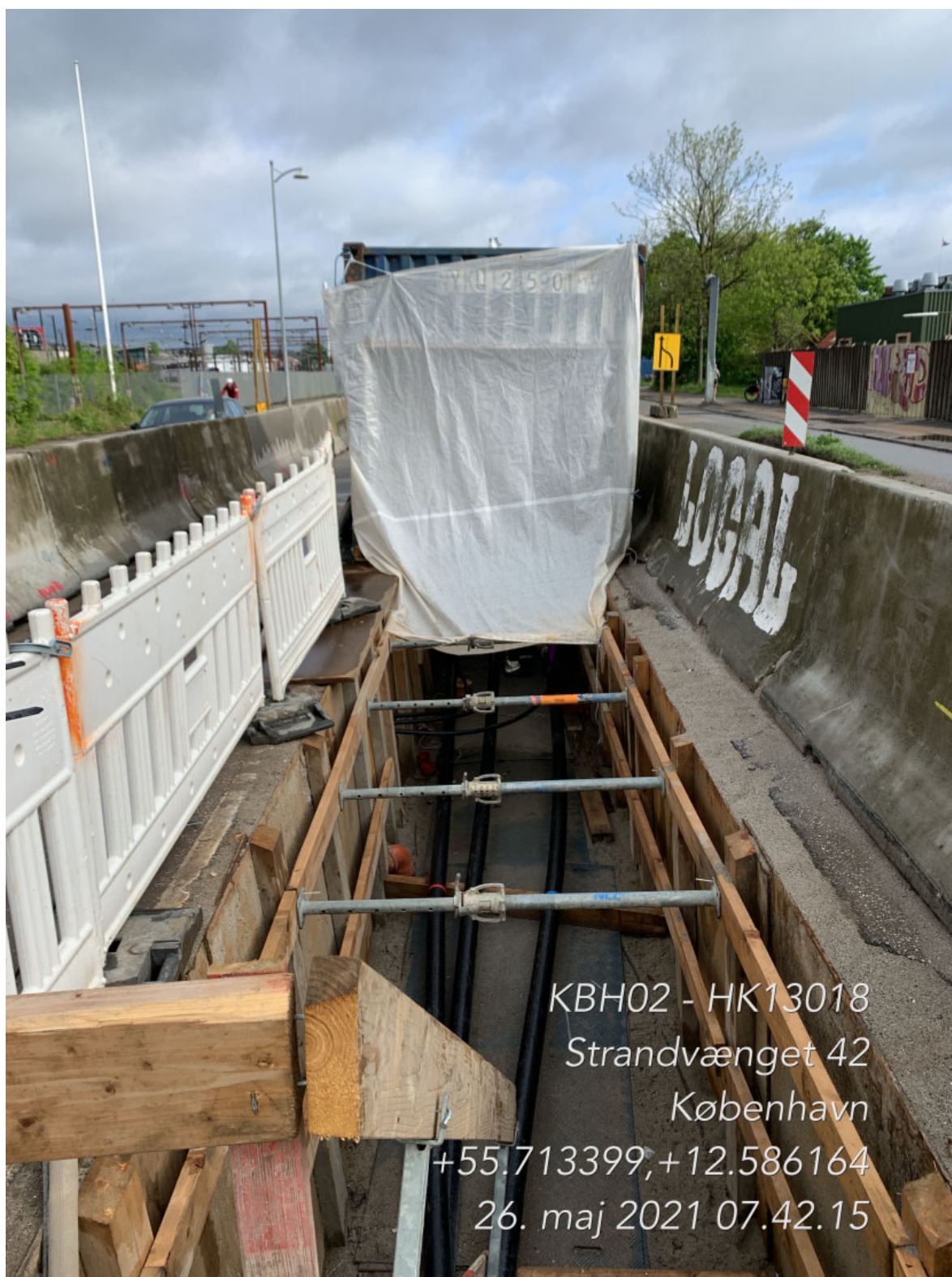
Figur 2-7: Eksempel på opstilling af container til samling af kabelmuffer. Fasekabler er ført ind i begge ender af containere, som er lukket mest mulig af for at kunne samle kablerne under rene, tørre og opvarmede forhold.
