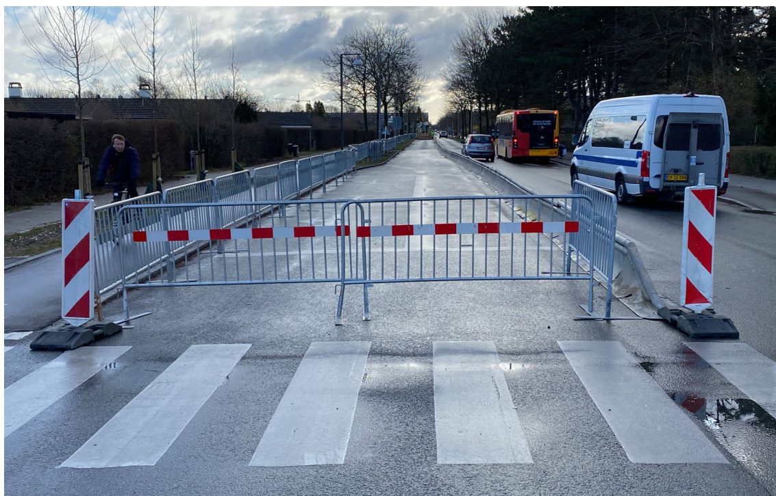
Figur 2-10: Eksempel på afspærring omkring midlertidige arbejdsarealer over en underboring.
