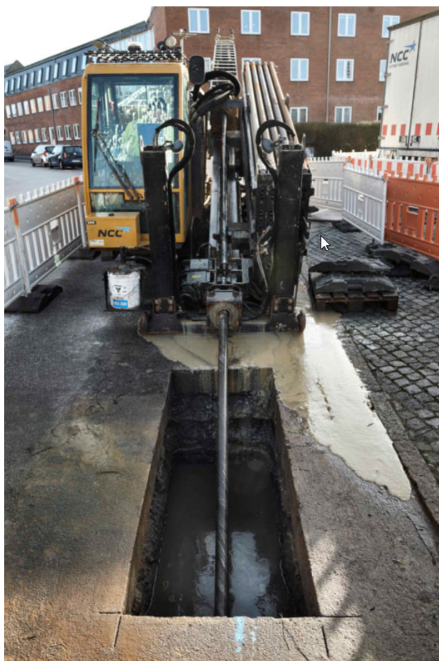
Figur 2-11: Eksempel på boremaskine, starthul og arbejdsareal ved styret underboring.
