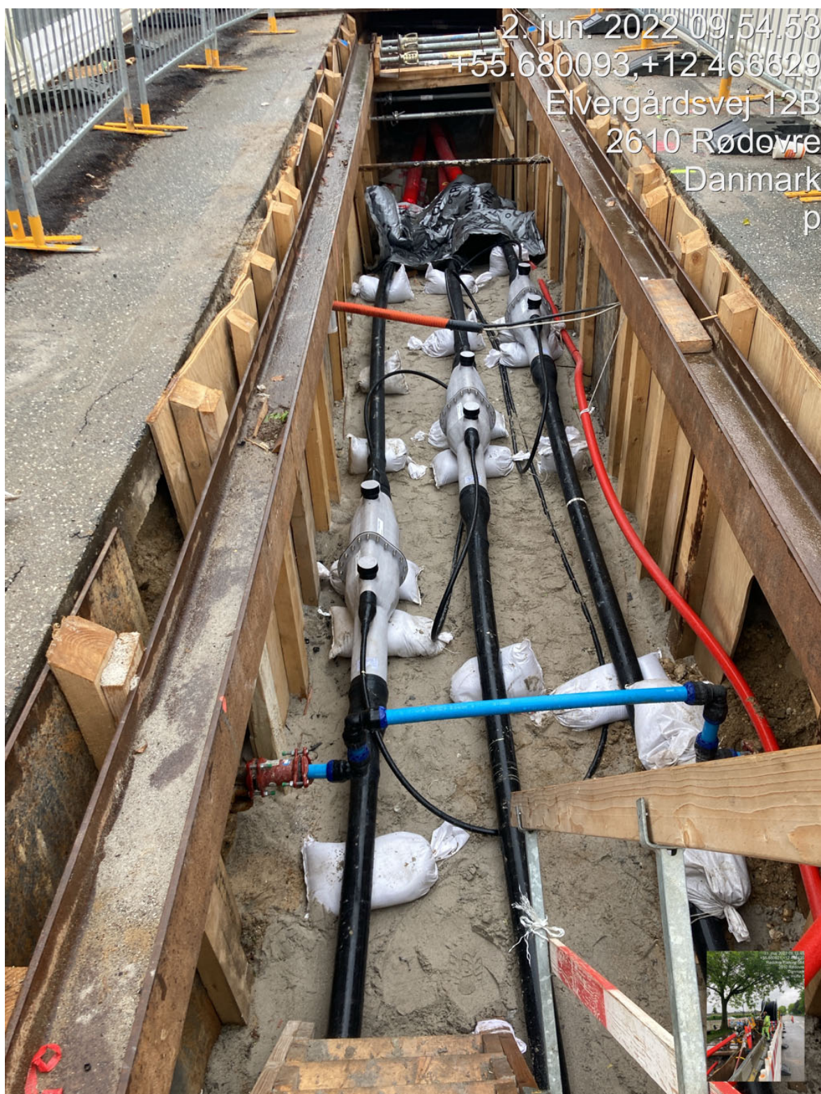
Figur 2-8: Kabelmuffe i åben kabelgrav med københavnerspuns. Der ses krydsende ledninger over kabelanlægget i kabel-graven. Den blå ledning er en vandledning, der er omlagt (hævet) for at give plads til kabelanlægget.
