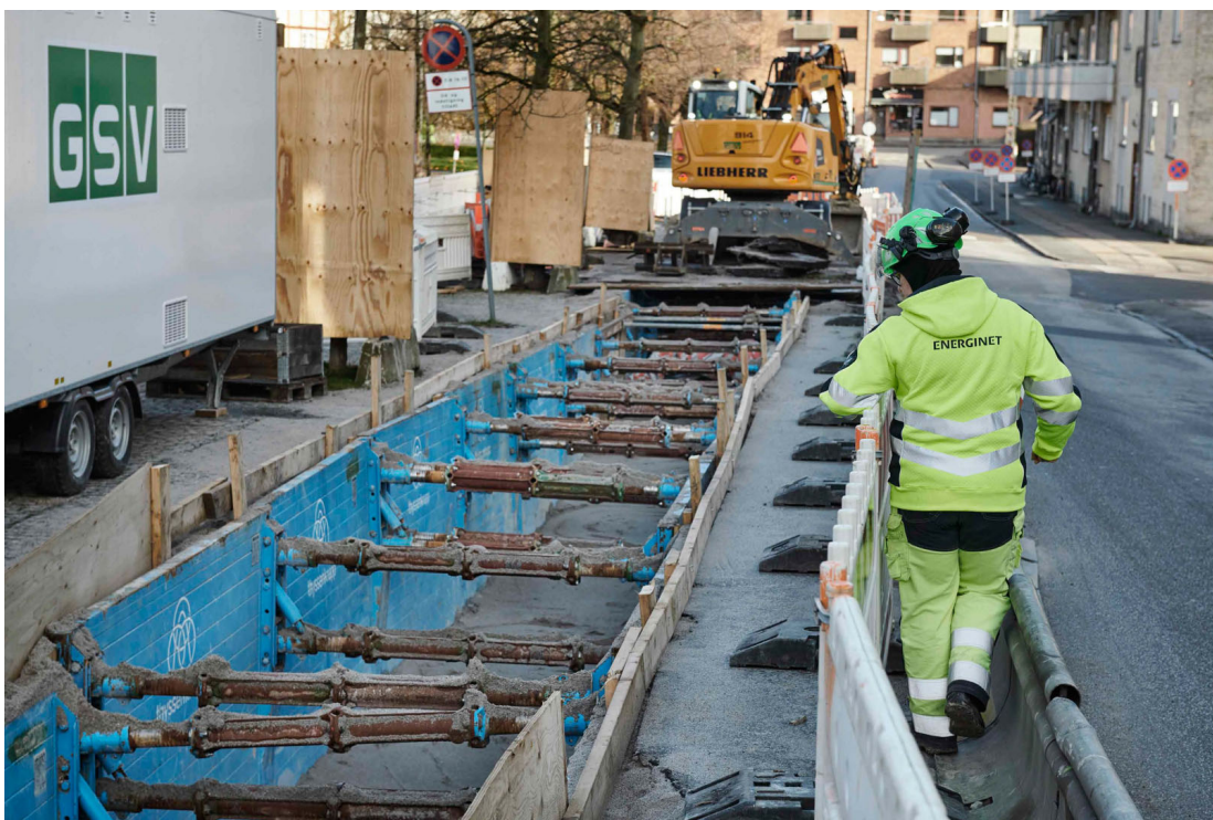
Figur 3-4: Åben kabelgrav med gravekasse. Arbejdsareal og afspærring ses. Der er påbegyndt opfyldning med sand.
