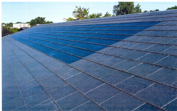
Integrerede solceller i tag Koncept roof - Naturskifer
