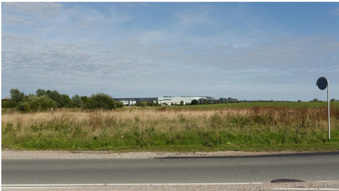
Figur 12.7: Fotostandpunkt 4 ved Peder Oxes Allé vest for FDBD. Udvidelsen vil ikke medføre en markant øget synlighed af anlægget. Den del af udvidelsen, der er synlig fra standpunkt 4, vil med dets grå farve falde i med bevoksningen omkring. NIRAS 2021.
