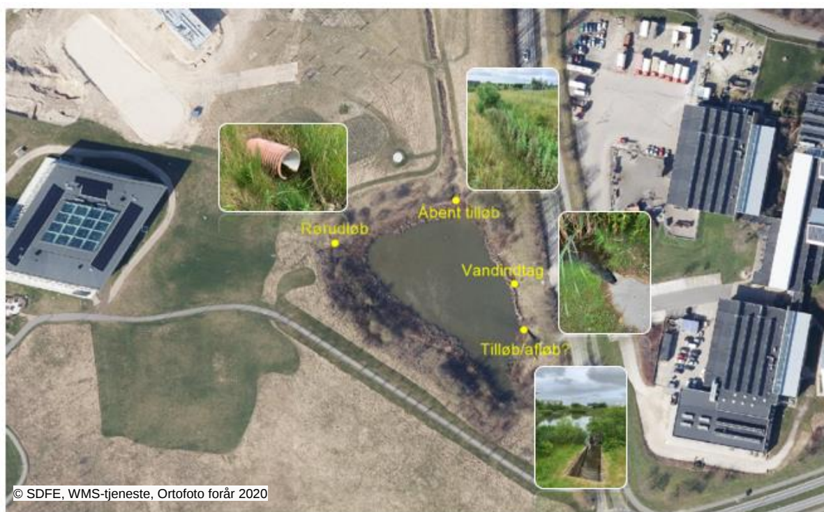
Figur 9.2: Tilløb og afløb af regnvansbassinet umiddelbart syd for projektområdet. Fotos er fra feltbesigtigelsen NIRAS den 22. juni 2021.
