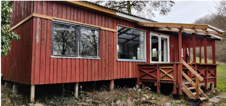
Ansøgers fotografi af det eksisterende sommerhus – øst- og sydfacade.
