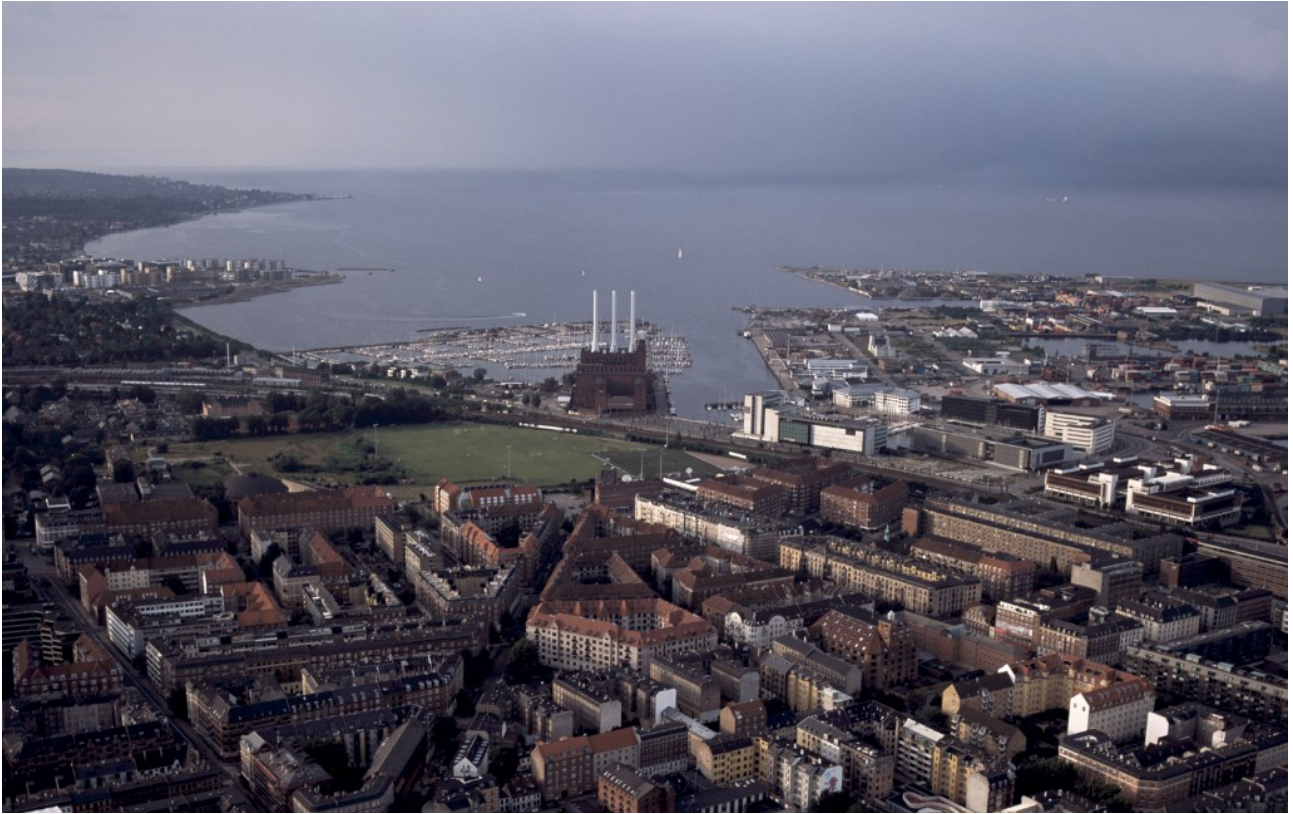
Figur 1 Svanemølleværket ses central på fotoet. Fotoet der ses i retningen nord/øst giver et overblik over nærområderne ved Svanemølleværket. I retningen syd-sydøst ses området Nordhavnen. Et område der byudvikles
