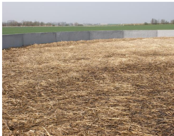
Figur 4. Eksempler på gyllelagre overdækket med organiske overdækningstyper. Til venstre vises et gyllelager overdækket med et naturligt flydelag, til højre vises et gyllelager overdækket med halm.
