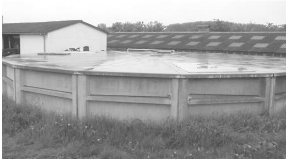
Figur 2. Eksempel på betondæk overdækning af gyllebeholder. Betondækket hviler på gyllebeholderens sider og en eller flere betonsøjler. Skitsen til højre viser overdækningsprincippet.
