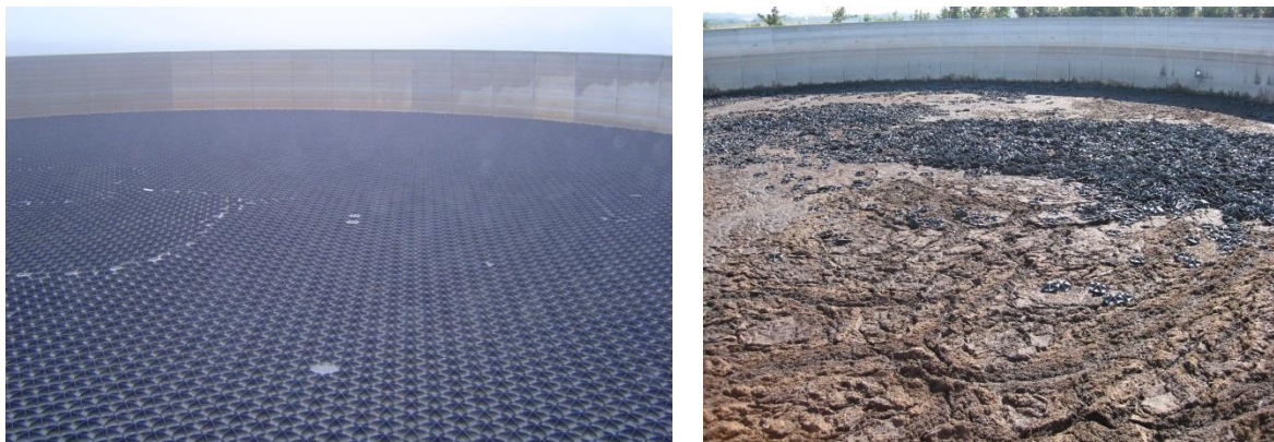
Figur 5. Billeder af flydebrikker (Hexa-cover) udlagt i gylletanke. Det venstre billede viser, at flydebrikkerne fordeler sig jævnt over gylleoverfladen. Billedet til højre viser, at der ikke sker en jævn fordeling af flydebrikker på gylletyper, der danner et naturligt flydelag.
