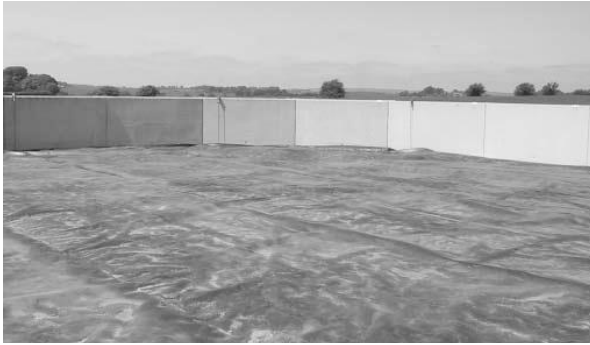
Figur 3. Eksempel på flydedugsoverdækning af gyllebeholder. Flydedugen flyder direkte på gylleoverfladen. Skitsen til højre viser overdækningsprincippet.
