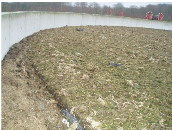
Figur 4. Eksempler på gyllelagre overdækket med organiske overdækningstyper. Til venstre vises et gyllelager overdækket med et naturligt flydelag, til højre vises et gyllelager overdækket med halm.
