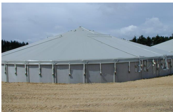
Figur 1. Eksempel på teltoverdækning af en gyllebeholder. Til højre ses et skematisk udsnit af overdækningsprincippet.
