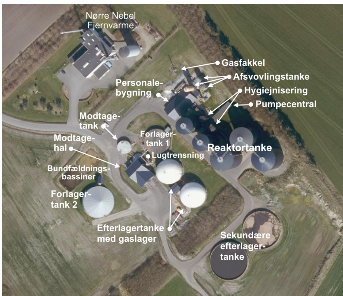
Figur 2 Luftfoto af det eksisterende biogasanlæg og Nørre Nebel Fjernvarme.
