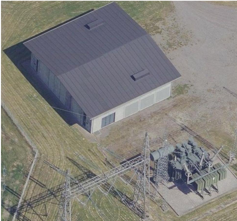
Figur 1-4. Eksempel på en bygning indeholdende et 220 kV-gasisoleret kompakt indendørs koblingsanlæg (GIS)
