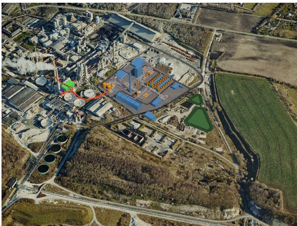
Figur 4-4 3D-model af CO 2 -fangstanlæg med tilkobling til de to største ovnsystemer ved Aalborg Portland set fra syd. Placering for kommende besøgscenter og skitsering heraf er medtaget og kan svagt anes nordøst for CO 2 -fangstanlægget selvom det ikke indgår i nærværende projekt.
