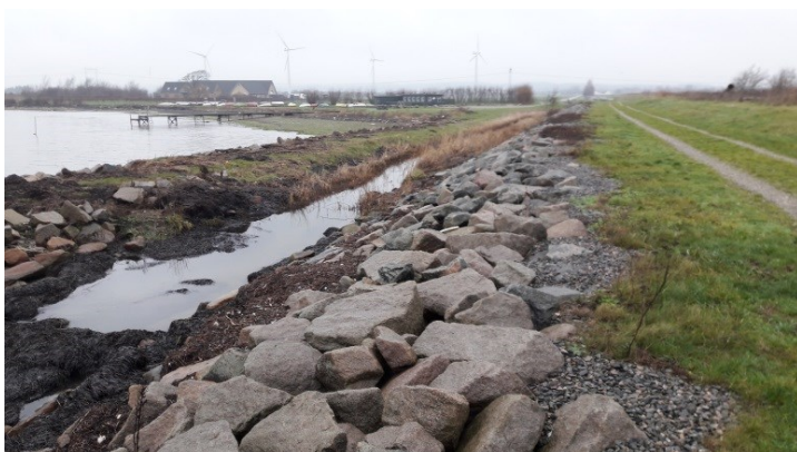
Foto 6. Deponiets afgrænsning mod Limfjorden med stenfæstning.
