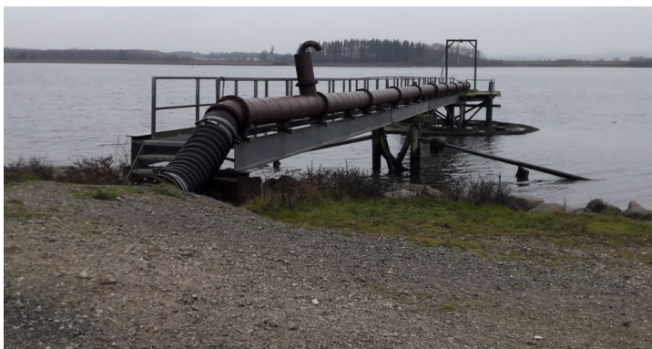
Foto 2. Anlæg til indspuling af sediment fra pram via fast rørledning fra anløbsbro til landfelterne.
