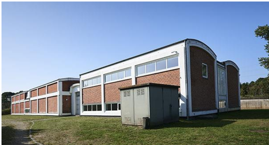
Trudsbro Vandværk, Kolding, TREFOR Vand A/S.
