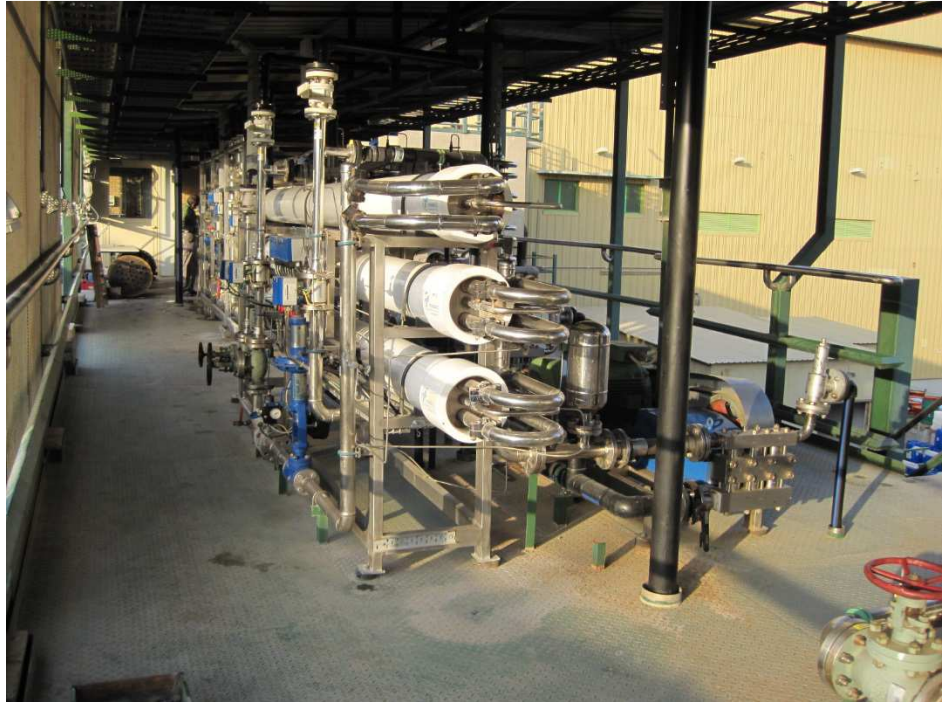
Nano-filtreringsanlæg på et danskbygget mejeri i Kuwait.
