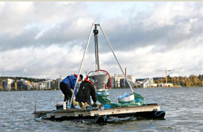
En iltpumpe bliver installeret i Vesijärvi. Pumpen bliver helt ned-sunket. Der vil kun være en bøjle synlig på overfladen. Foto: ESS/Leena Liukkonen.
