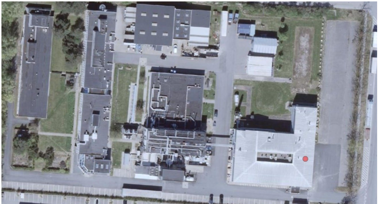
Luftfoto af COS på Kanalholmen, Avedøre Holme i Hvidovre Kommune.
