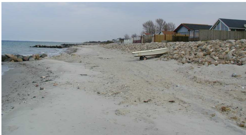
Figur 4.20 Ny skråningsbeskyttelse ved Høfde 63, april 2004
