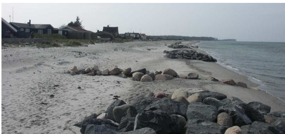
Figur 4.14 Bred strand bagved de fire nye bølgebrydere ved Tørresø Høfde 55, juni 2005, juli 2006, april 2010
