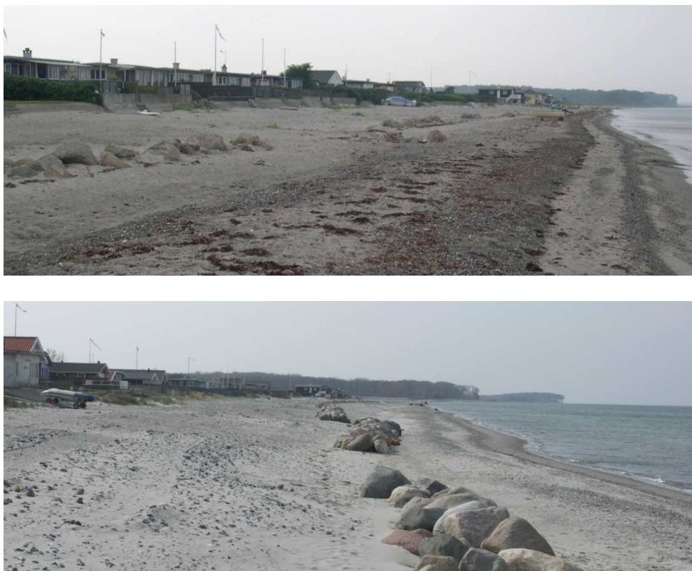
Figur 4.13 Bølgebrydere dækket af sand i den vestlige del af Tørresø, 11. juli 2006, 29. april 2010, Høfde 52
